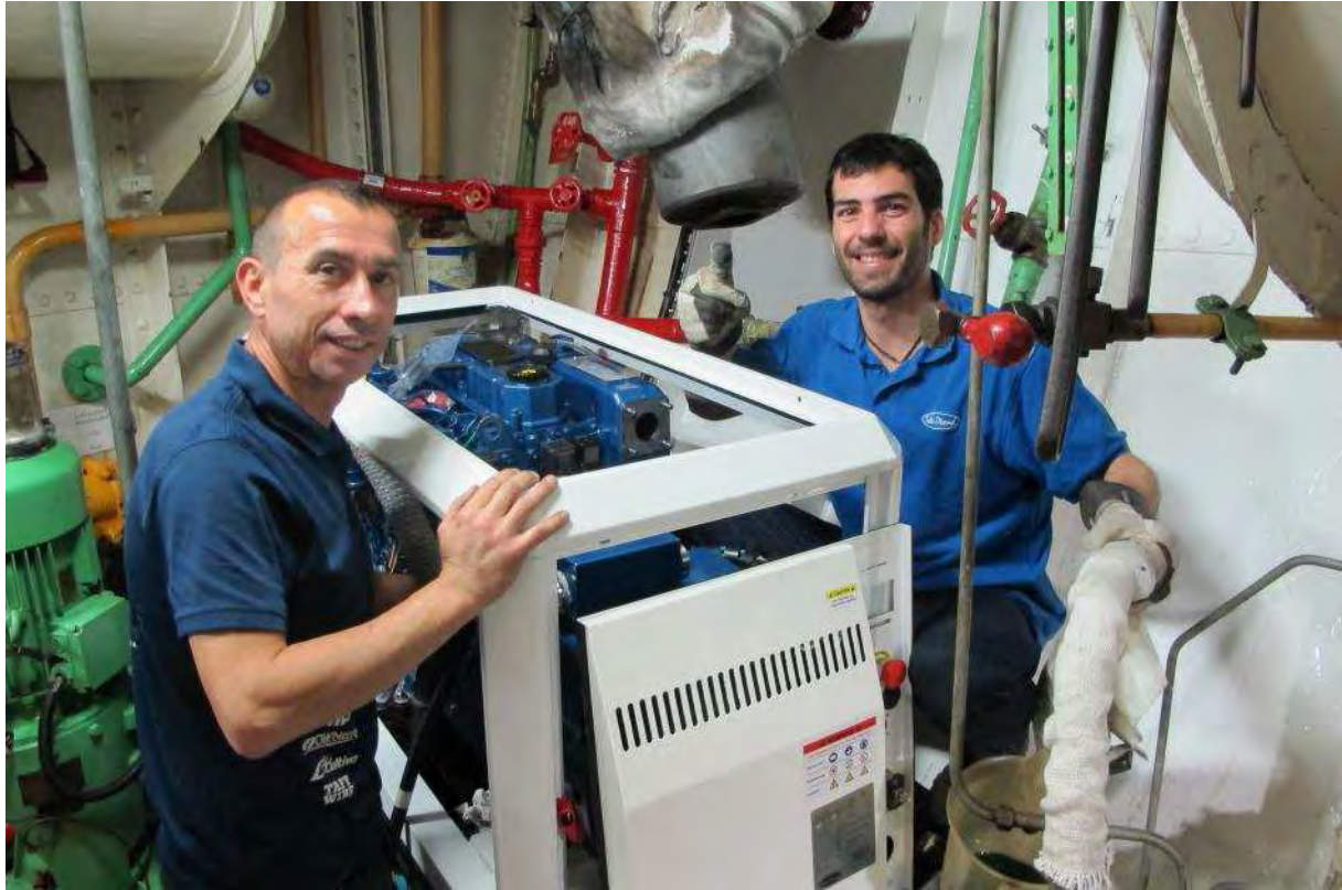
De två duktiga teknikerna Jorge och Eloy installerar det nya Solé-elverket.
